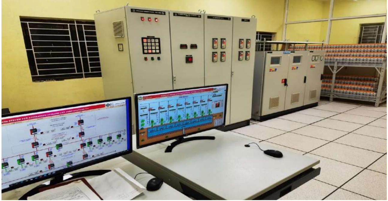
ஈரோடு மாவட்டம் - பவானி வட்டம், அத்திக்கடவு அவிநாசி நீரேற்று திட்டம், தானியங்கி கட்டுப்பாட்டு அறை (SCADA), பவானி - மதிப்பீடு ரூ. 1756.88 கோடி - மாநில நிதி
