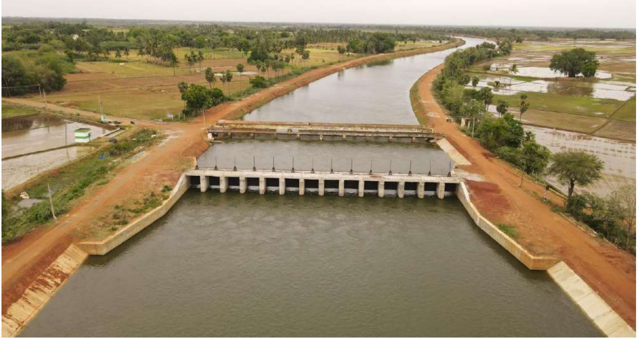
தஞ்சாவூர் மாவட்டம் - கல்லணைக்கால்வாய் அமைப்பில் நீட்டித்தல், புனரமைத்தல் மற்றும் நவீனப்படுத்துதல் - குருவாடிப்பட்டி கிராமத்தில் புதிய நீரொழுங்கி (சிப்பம் எண்.2) - (மதிப்பீடு ரூ. 192 கோடி) - மாநில நிதி
