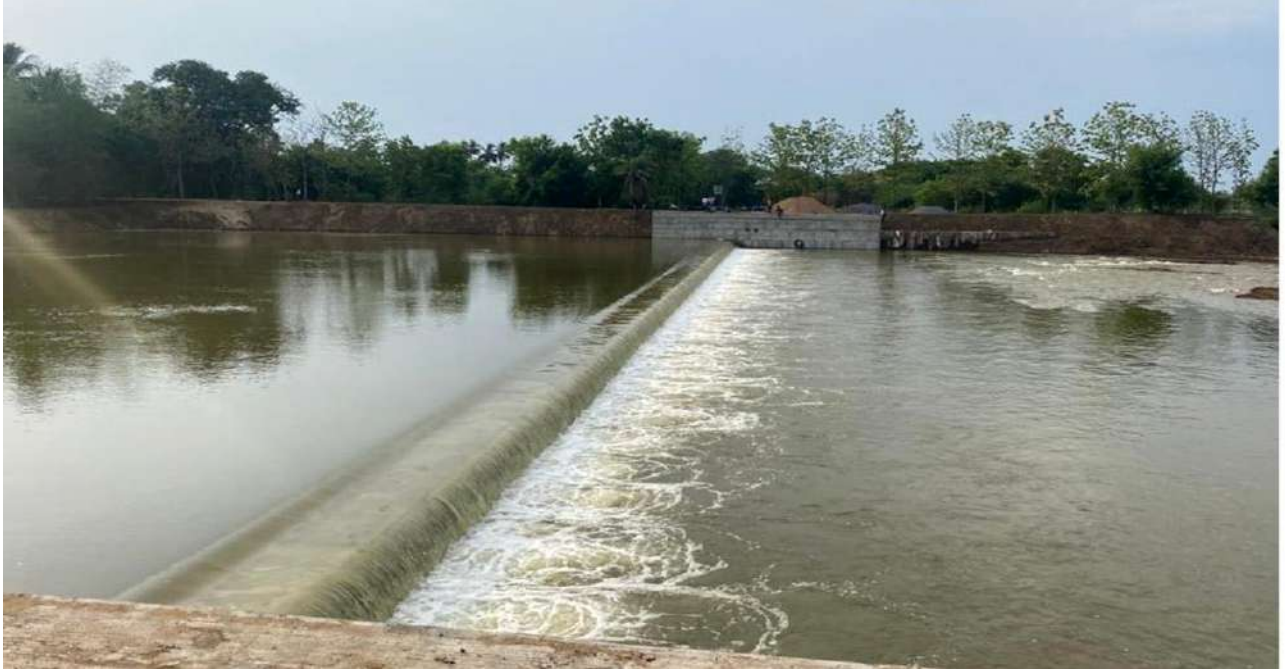
தஞ்சாவூர் மாவட்டம் - சுரைக்காயூர் கிராமத்தில் வெட்டாற்றின் குறுக்கே நெடுகை 73.635 கி.மீ-இல் தளமட்ட சுவர் - ( மதிப்பீடு ரூ. 4.88 கோடி )- நபார்டு
