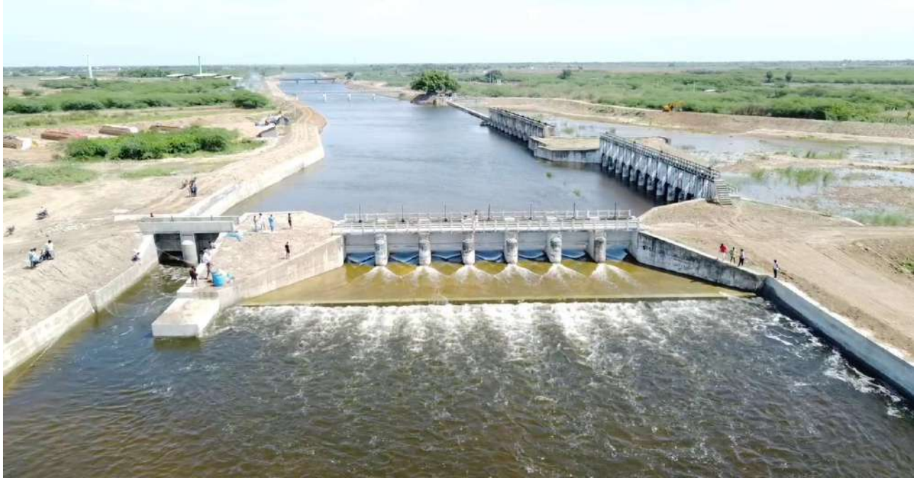
இராமநாதபுரம் மாவட்டம் - இராமநாதபுரம் பெரிய கண்மாயின் வரத்துக்கால்வாயின் குறுக்கே உள்ள தலைமதகில் கூடுதல் மதகுகள் கட்டும் பணி மதிப்பீடு ரூ.9.93 கோடி - மாநில நிதி
